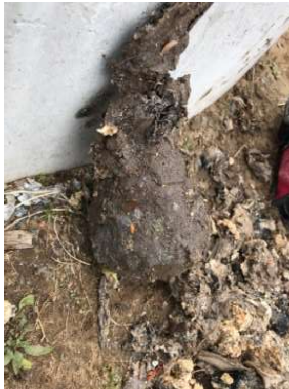
Accumulation de débris sur une flotte (STEP 2020-05-04)
