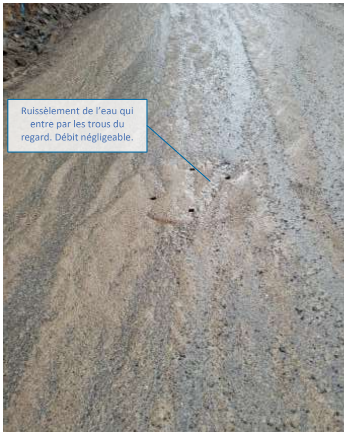
Exemple d'un couvercle de regard SANS bouchon (2021-03-26)
