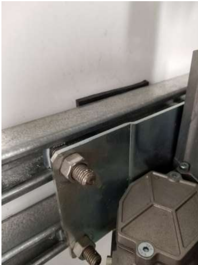
Ajout de coussinets derrière les ancrages des soufflantes – Vue de près (2020-12-08)
