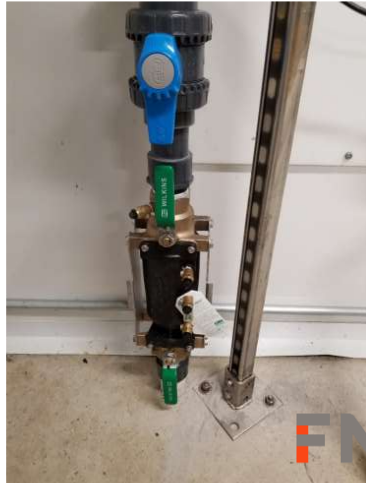
Ajout d'un DAR – Vue de proche (2021-02-24)
