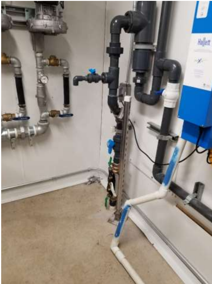
Ajout d'un DAR – Vue d'ensemble (2021-02-24)
